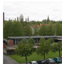
Bygg nr. 17: Velferdsbygningen (1969-1970)
